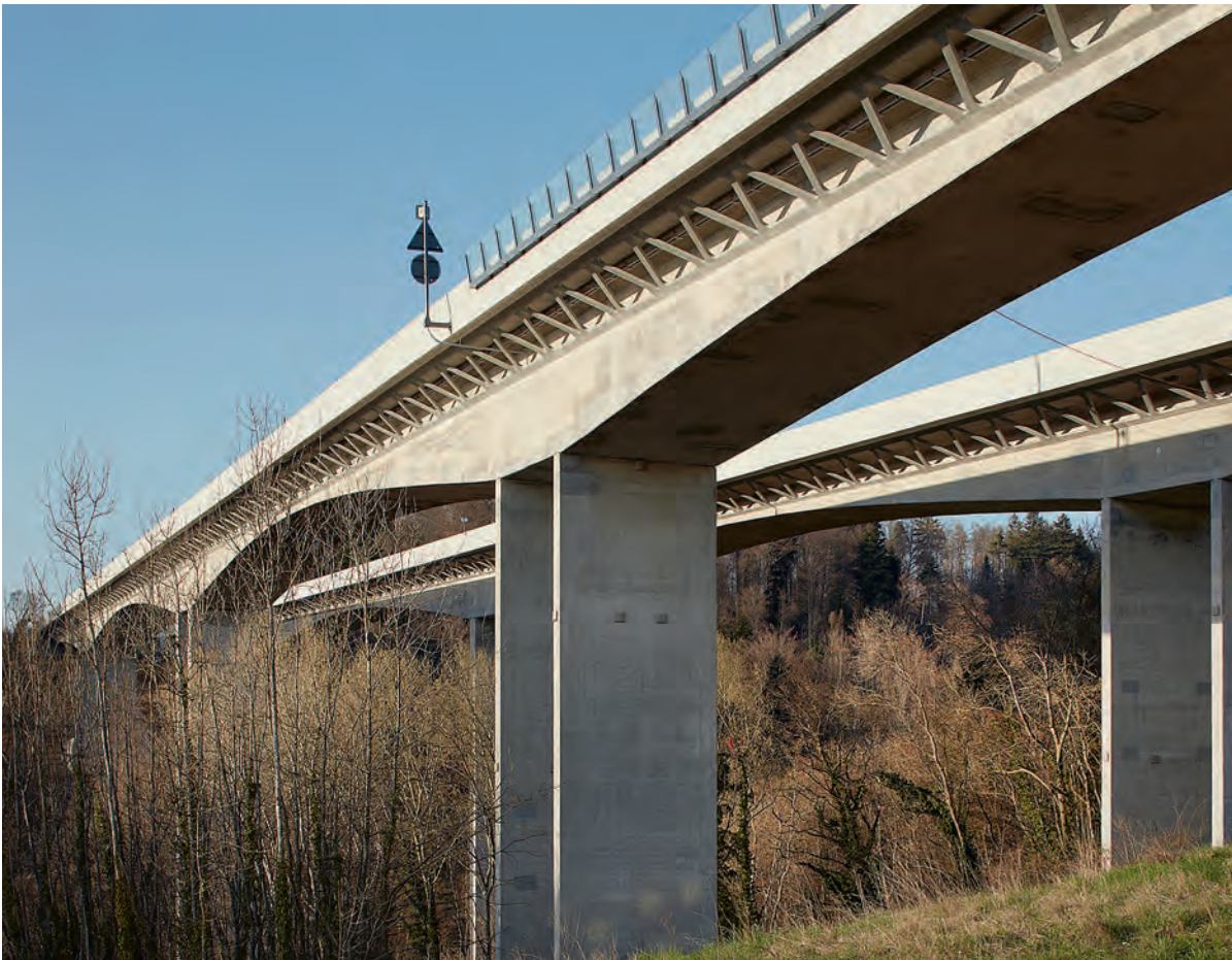
Fig. 6 Vue des ponts modernisés. View of the modernised bridges.
