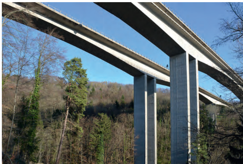
Fig.1 Vue des ponts avant travaux. View of the bridges before the works.
