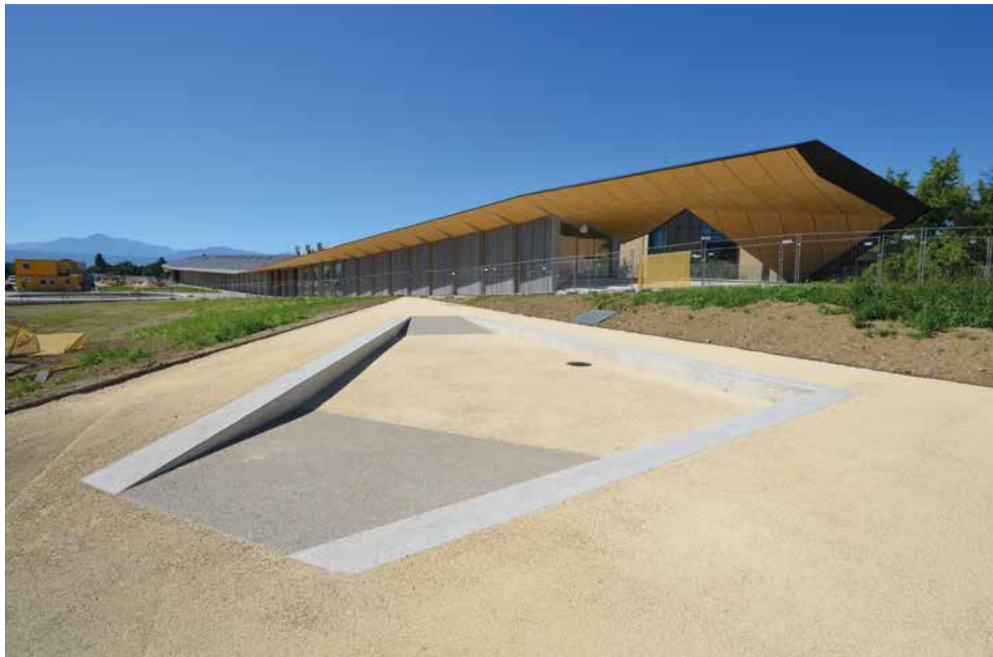
8 Vue d'ensemble du pavillon depuis la toiture nord (Sauf mention, tous les documents illustrant cet article ont été fournis par INGPHI SA.)
