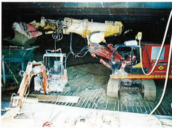
Aushub unter Spriesslage bis UK Tunnelsohle, mit Aufgabe des Materials auf Förderbandanlage
