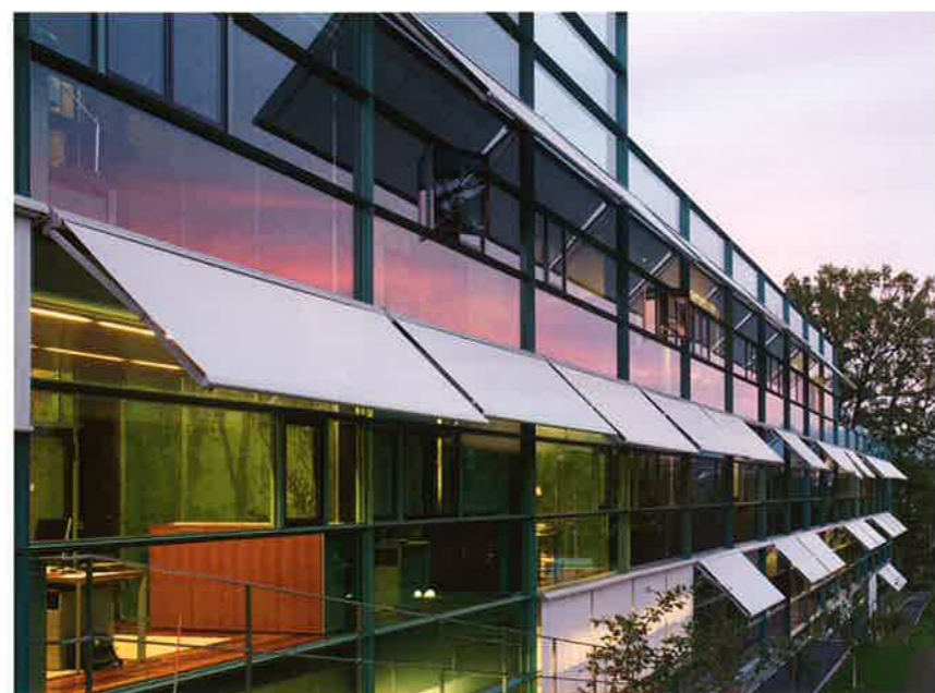
De jour, les façades reflètent ciel et parc. Les dispositifs de protection solaire peuvent être réglés individuellement.
