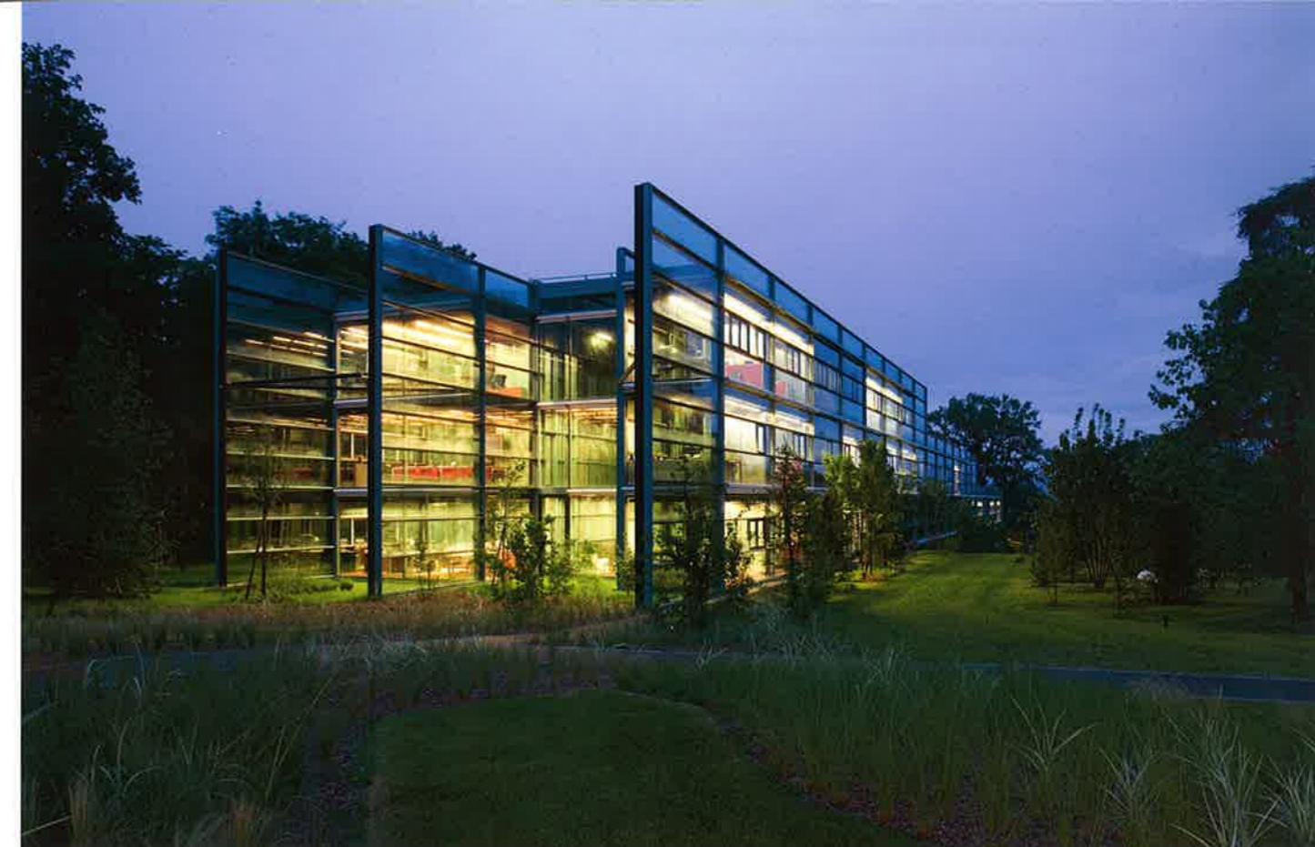
Au crépuscule, les vitrages mats avec motifs végétaux sérigraphiés disposés à l'intérieur s'illuminent.
