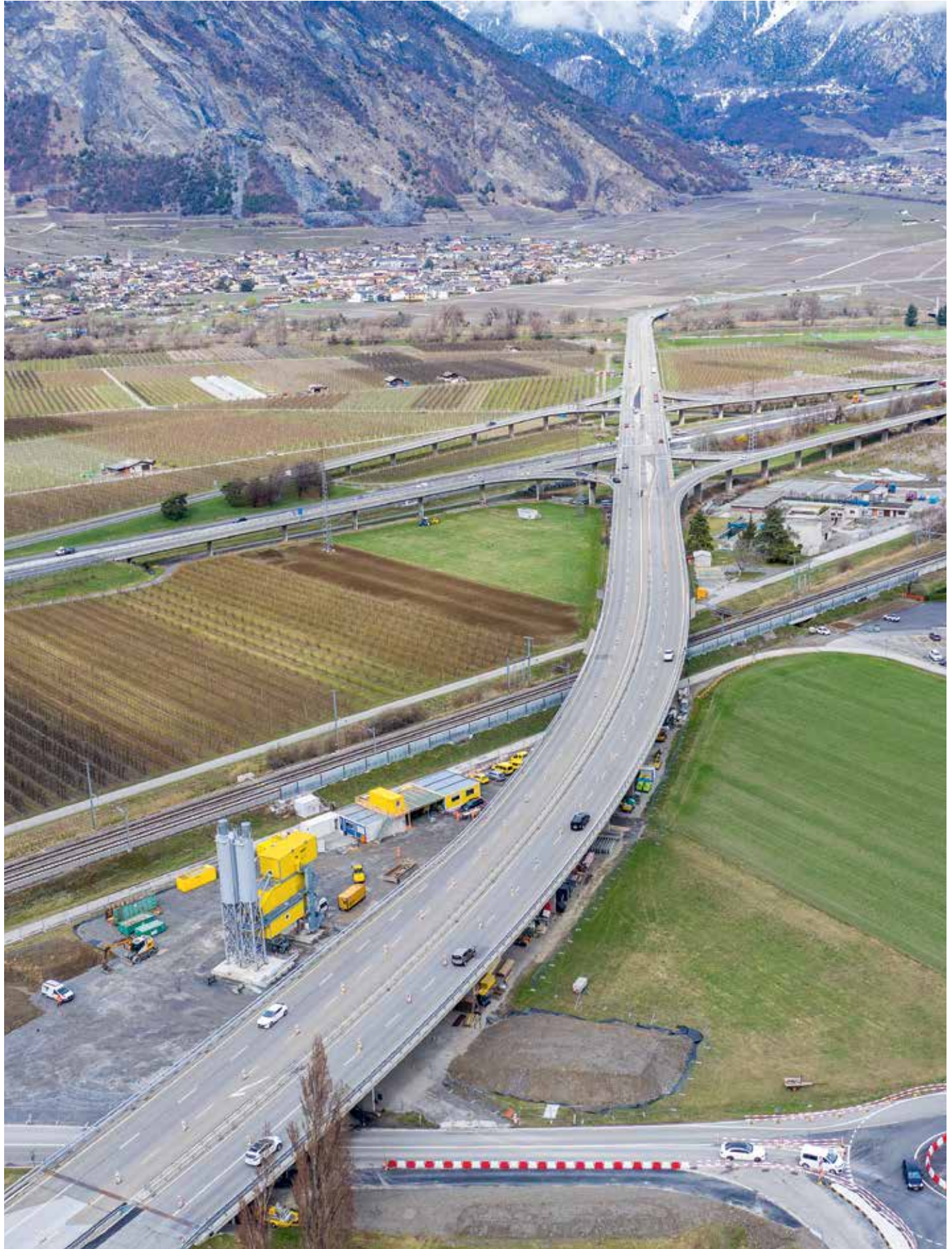
Vue du viaduc de Riddes en direction du nord (OFROU)
